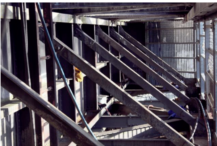
Baustelle im Wehrschütz des Wehres Beihingen (Bild: Wasser- und Schifffahrtsamt Stuttgart).
