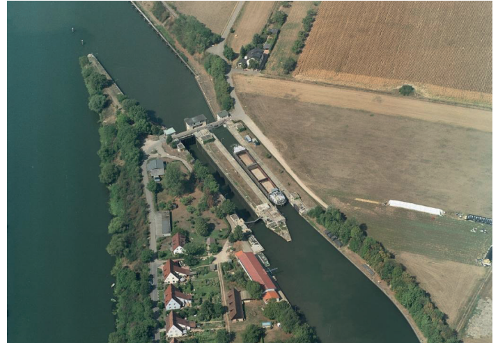
Luftbild der Schleuse Schwabenheim (Foto: WSA Heidelberg)
