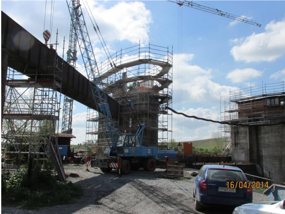
Vorarbeiten für den Aushub des Wehrverschlusses am ersten Wehrfeld: Aushub des Verbindungssteiges zum ersten Wehrpfeiler, dessen Antriebs- haus bereits abgetragen wurde.
