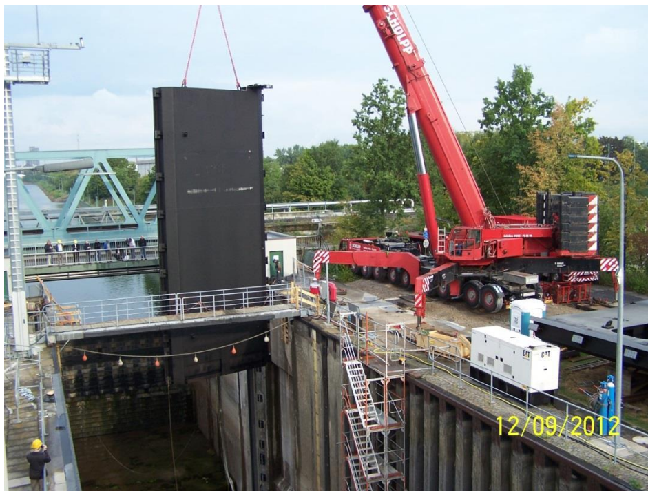
Schleuse Mannheim-Feudenheim, Einhub neuer Unterhaupttore für die rechte Kammer, 2012
