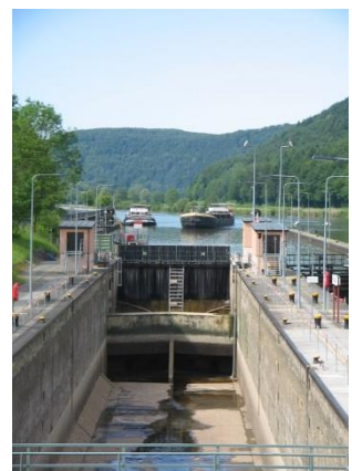
Rechte Kammer der Schleuse Guttenbach, trockengelegt
