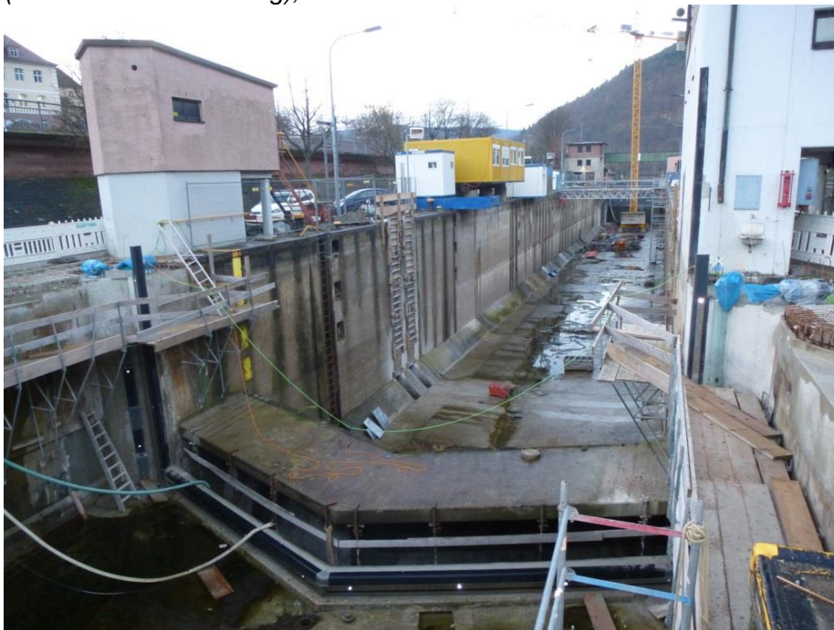
Aktueller Stand der Vorbereitungen zum Einbau der Tore (im Vordergrund Ansicht des Oberhauptes, im Hintergrund das Unterhaupt).
