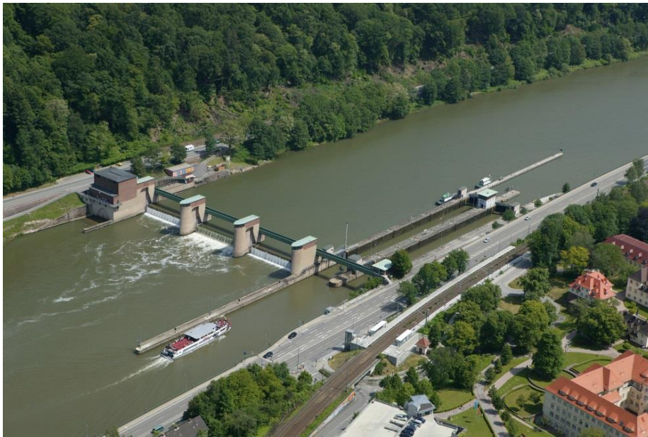
Stauhaltung Neckargemünd von Südwesten aus gesehen mit Schleuse (linke Kammer landseitig), Wehr und Kraftwerk.
