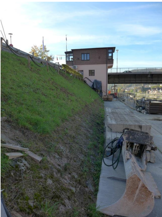
Bereich der Arbeiten, Böschung an der Zufahrt des Unterhauptes der Schleuse Hirschhorn
